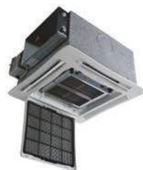
Detalle de registro del filtro
